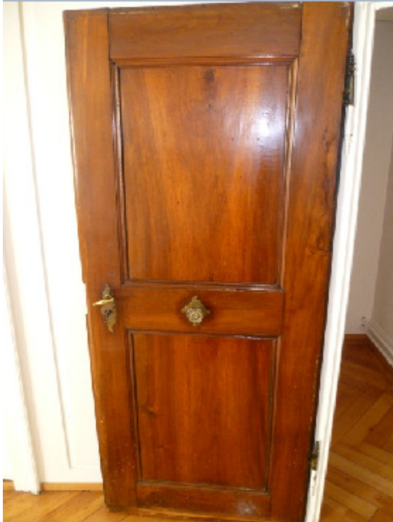
Nußbaumtür u. Metallbeschläge. Niederdorfstr. 22, 8001 Zürich
